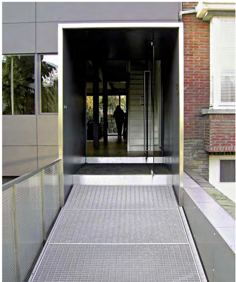
*Eine Rampe mit einer Lauffläche aus verzinkten Gitterrosten überbrückt den Höhenunterschied zwischen der Straße und dem Erdgeschoss.*
