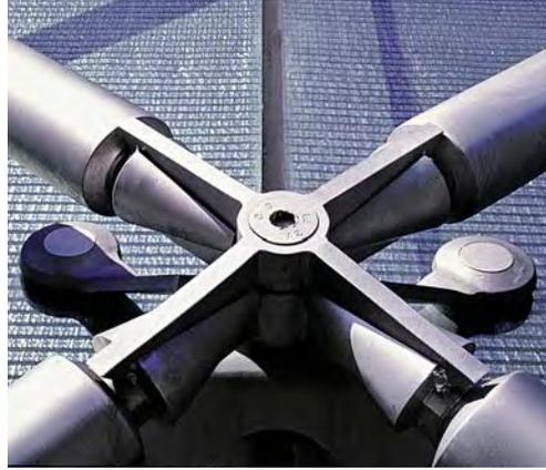
Zur Fixierung der Verbindungsteile aus nichtrostendem Stahl ist nur eine Schraube nötig, was eine schnelle Montage auf der Baustelle ermöglichte.
