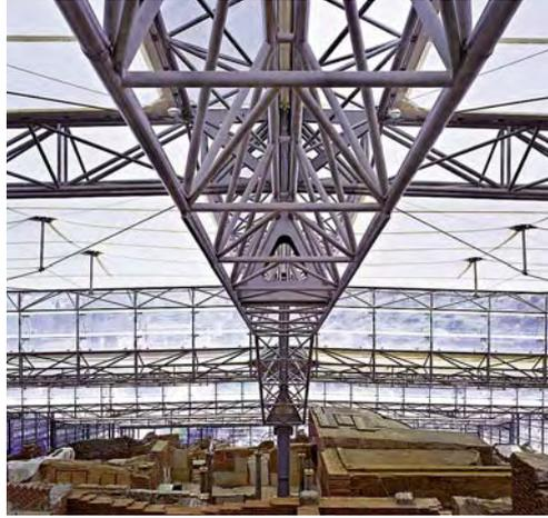
*Die nichtrostende Stahlkonstruktion wurde in Österreich produziert, in vormontiertem Zustand nach Ephesos transportiert und innerhalb weniger Monate montiert.*
