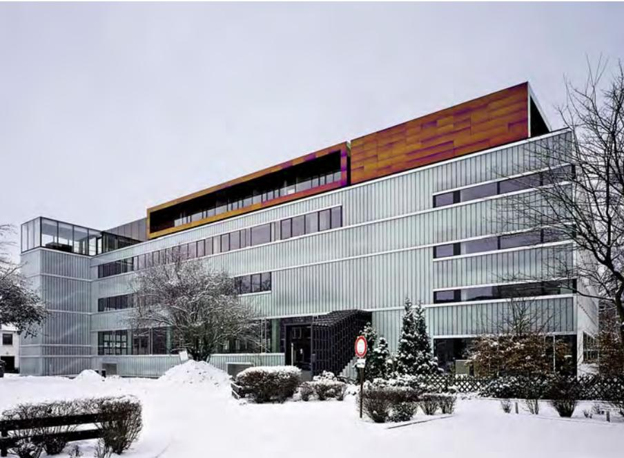
*An der Fassade der Aufstockung wechseln sich transparentes und pinkfarben verspiegeltes Glas mit mattierten und polierten, elektrolytisch rot gefärbten nichtrostenden Stahlblechen ab.*
