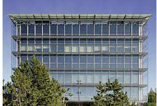
Das Verwaltungsgebäude in der Nähe des Flughafens Vantaa wurde 1979 als Betonskelettbau mit einer Aluminium-Glas-Fassade errichtet. Durch starke thermische Ausdehnung und Undichtigkeiten wies die Fassade mittlerweile erhebliche Schäden auf.
