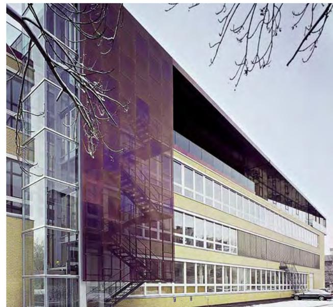
Aufstockungen sichtbar: Eine unverwechselbare Haut aus verspiegeltem Glas und elektrolytisch gefärbtem nichtrostendem Stahlblech gibt den Bauten Identität. Der rotviolette Farbton – die Hausfarbe der Agentur – verändert sich je nach Sonneneinstrahlung durch Interferenzeffekte an der Oberfläche der Bleche von Orange über Rottöne bis hin zu Grün.
