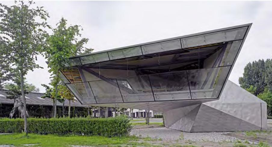
*Der weit auskragende, mit nichtrostendem Stahl verkleidete Baukörper öffnet sich mit einer großflächigen Verglasung zu dem angrenzenden Polofeld.*
