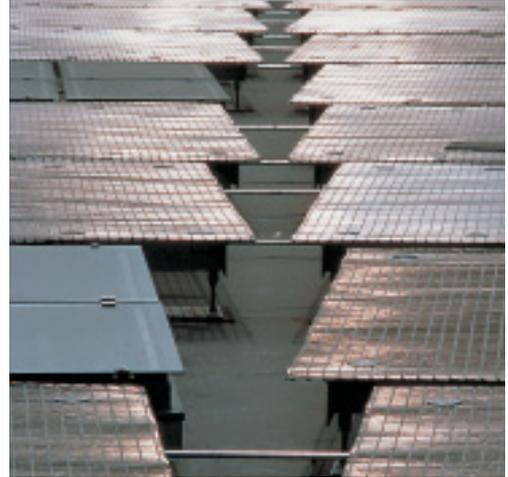
*Oberlichter und Metallgewebe befinden sich in einer Ebene, so daß die gesamte Dachfläche von weitem als einheitliche, geschlossene Struktur erscheint.*
