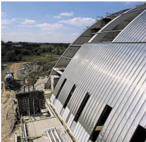
*Das in Stehfalztechnik ausgeführte Kaltdach wurde aus konstruktiven Gründen – Scharenlänge und Hinterlüftung – horizontal abgesetzt.*
