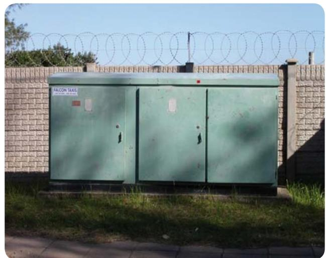
Stromverteilerkasten aus beschichtetem 1.4003 (410), Südafrika
