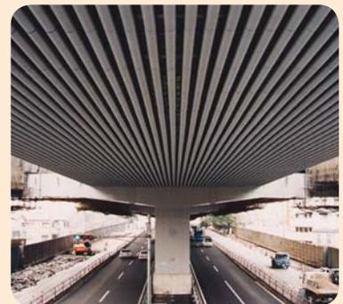
Schallabsorbierende Brückenverkleidung, Japan.
