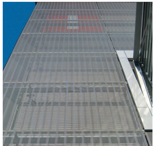
Vertikale Runddrahtgruppen im Webmuster verleihen der Fassade ihre auffällige Nadelstreifenoptik.
