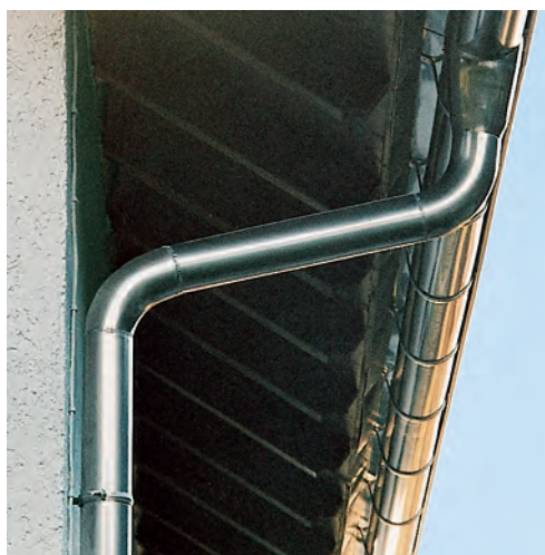
Regenfallrohre in den Standardoberflächen 2B (glänzend, rechts) und 2D (matt, links)
