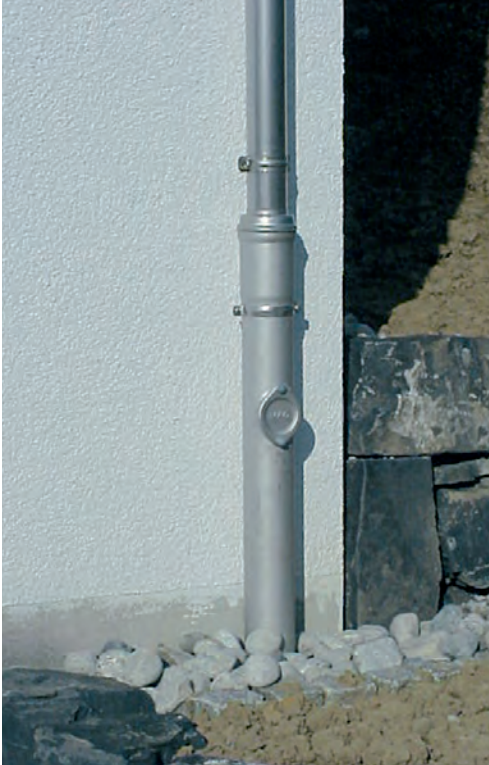
Standrohr mit Reinigungsöffnung
