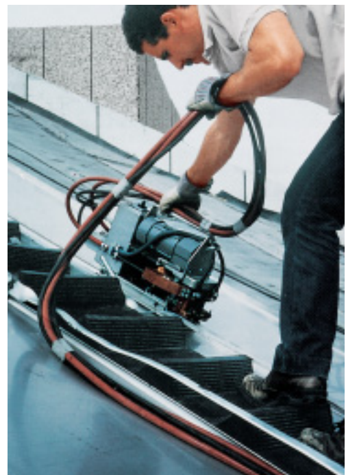
Rollnahtschweißmaschine mit wasser-gekühlten Elektroden.
