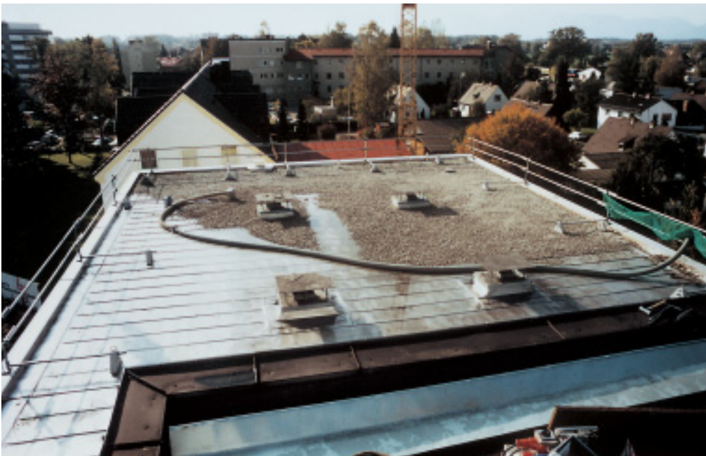
Aufbringung von Kies auf das Dach.
