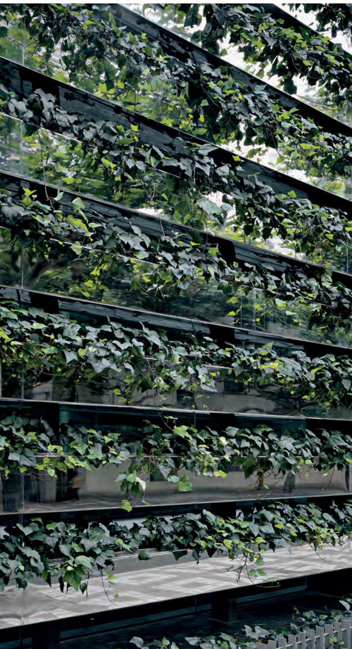
Die Bepflanzung der spiegelnden Kästen verwandelt die Fassade aus Stahl und Glas in eine grüne Wand.
