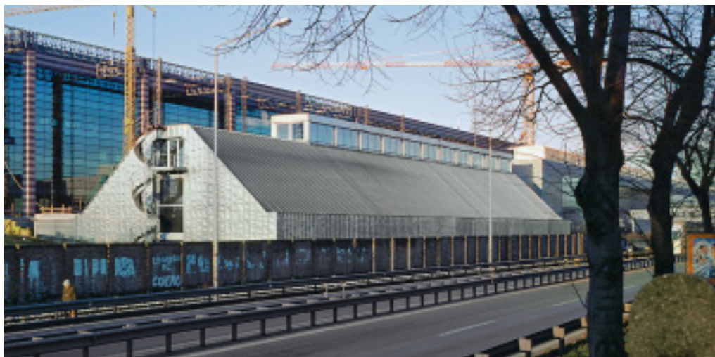
Un ancien entrepôt reconverti en immeuble administratif et hall d'exposition.
