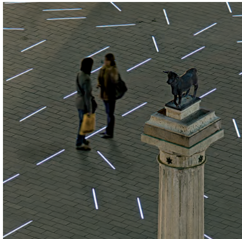
Les réglettes à LED encastrées dans le revêtement en pavés de basalte sont installées dans des boîtiers en acier inoxydable EN 1.4304 de 2 mm d'épaisseur, et protégées par un capot en verre feuilleté, affleurant.
