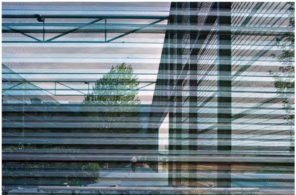
*Nella città olandese di Woerden, uno schermo semi-trasparente separa dalla strada i cortili di questo edificio per uffici e laboratori. Le pareti di 10 m di altezza sono realizzate in lamiera forata a profilo trapezoidale (EN 1.4436, finitura 2B), con un rapporto vuoto-pieno del 50%.*
