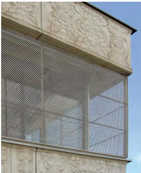
La punzonatura è il modo più economico per produrre lamiere forate. A livello industriale si utilizzano presse di varie dimensioni per produrre fori singoli o file di fori tanto sui fogli di lamiera che direttamente sul nastro. La punzonatura procede sempre in un'unica direzione perpendicolarmente al piano della
