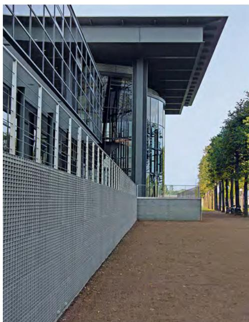
*L'ombreggiatura della Mediateca di Sélestat in Francia è ottenuta mediante grigliati saldati in acciaio inossidabile.*
