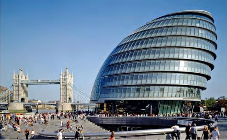
*La forma e l'orientamento della City Hall sono stati concepiti per ridurre il consumo energetico dell'edificio, sfruttando al massimo il volume interno.*
