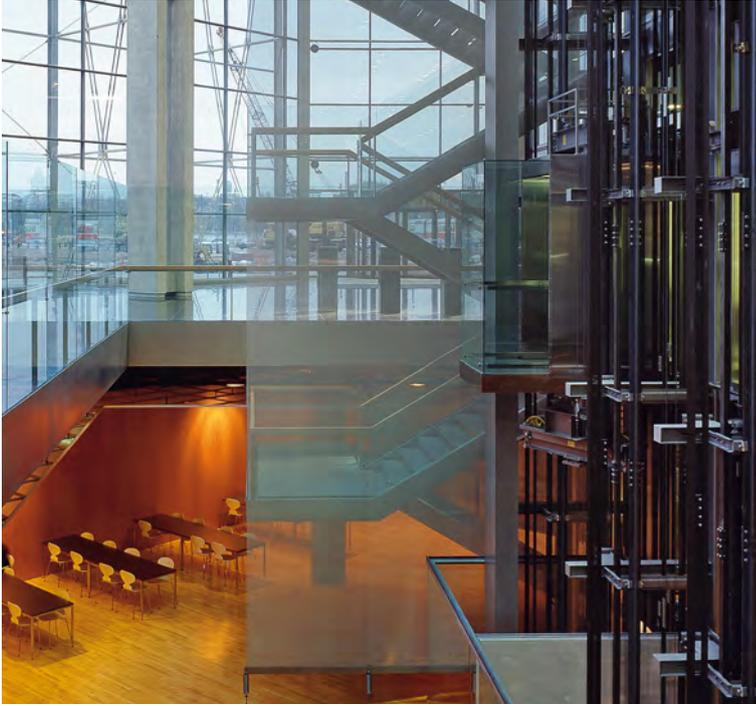
*Nell'ingresso del Sanoma Building di Helsinki, un'unica tela metallica avvolge i nove piani della grande scala e costituisce un parapetto di sicurezza.*
