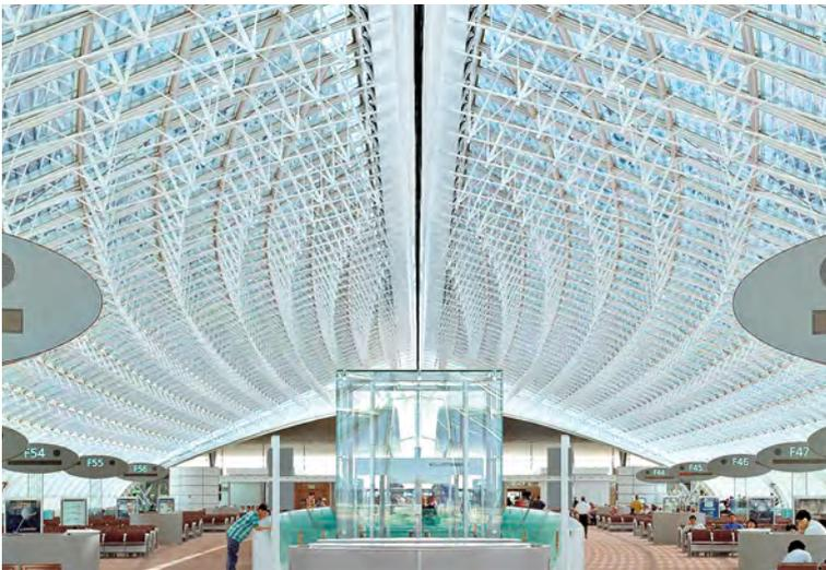
*Nell'aeroporto parigino di Roissy-Charles de Gaulle, una struttura in lamiera inox ad onde trapezoidali ricopre la vetratura esterna del tetto riparando la sala partenze dai raggi del sole.*
