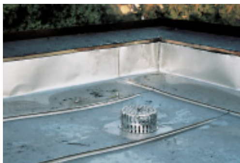
Chiusino eseguito su misura (in alto), chiusino installato completo di griglia (sotto).
