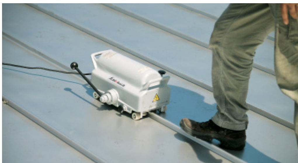
Macchina e attrezzi manuali usati per l'aggraffatura
