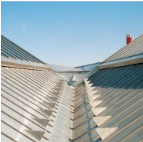
*Le aperture protette, nel canale di scolo, consentono la ventilazione della struttura del tetto.*
