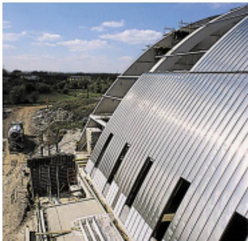
*Il tetto in acciaio inossidabile con giunzioni aggraffate è disposto in sezioni orizzontali per comodità di movimentazione dei nastri di acciaio e per consentire un'adeguata circolazione dell'aria nel tetto ventilato.*
