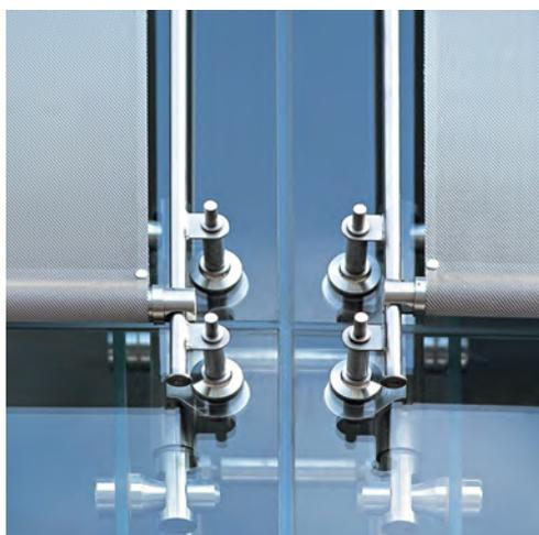
*I frangisole scorrono su guide speciali in acciaio inox, collegate ai punti di fissaggio.*
