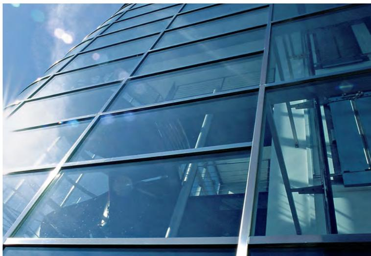
un'ulteriore riduzione dello spessore degli elementi metallici, in quanto i carichi del vento e il peso specifico dei pannelli vengono trasmessi alla struttura attraverso dei fissaggi per punti rigidi o snodati, che soddisfano le condizioni più estreme di resistenza alla corrosione e durata. Salendo ancora di livello, sottili tiranti ad elevata resistenza in acciaio inossidabile permettono di realizzare facciate e coperture spettacolari, dove il vetro stesso funge da materiale portante.
