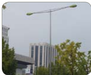
Nuance 1.4510/439, tube soudé et électro-poli, KOSA, Séoul, Corée du Sud
