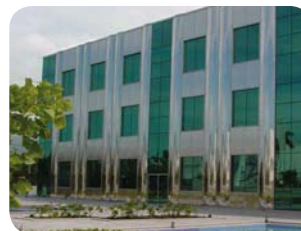
Edificio parzialmente rivestito in 444, Brasile.
