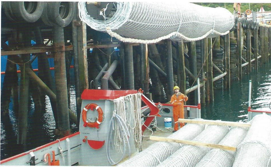
Die Stahlnetze aus dem Kanton Thurgau werden eingeschifft.
