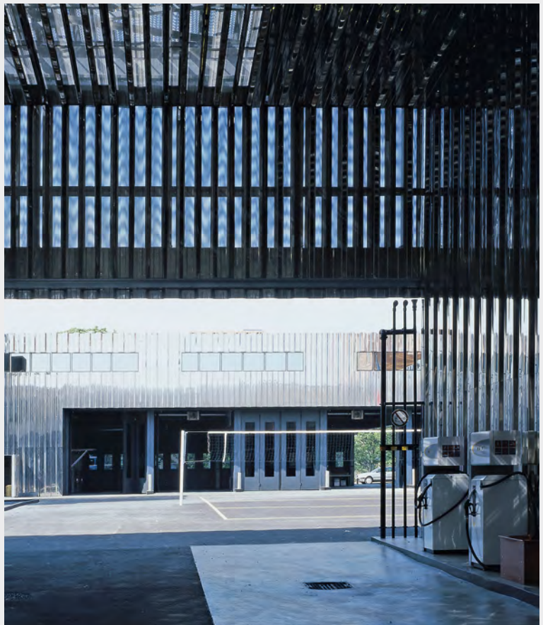
Durch perforierte Flä- chen in der Fassade und dem Dach fällt Tageslicht in den Zufahrtsbereich.
