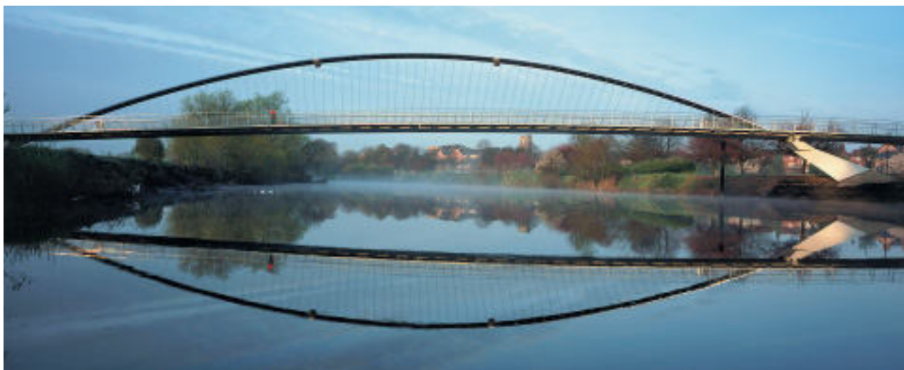
Der Edelstahlbogen ist um 50^\circ aus der Senkrechten geneigt und spannt 80 m weit.
