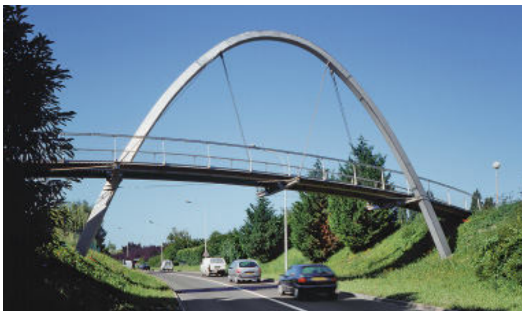
Sous l'arc d'acier inoxydable, le tablier de pont à la ligne élancée surplombe la route à grande circulation.
