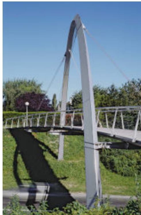
La coupe transversale triangulaire se rétrécit, de la fondation au sommet de l'arc.
