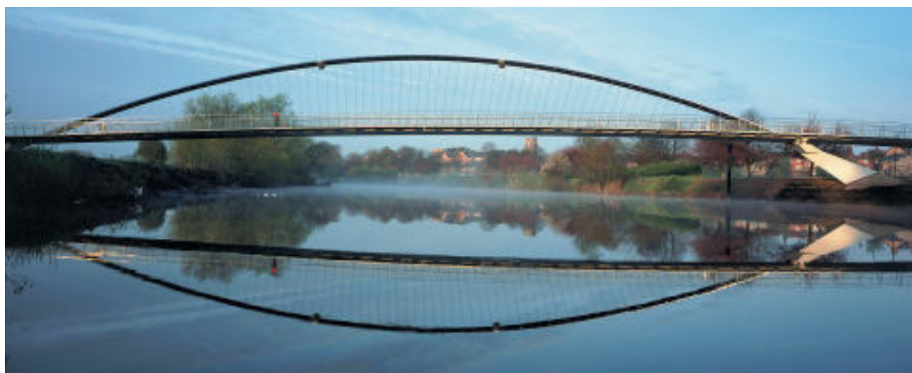
Incliné de 50° par rapport à la verticale, l'arc en acier inoxydable atteint 80 m d'envergure.
