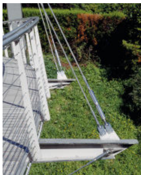
Des tirants disposés par paires relient les poutres transversales à l'arc.
