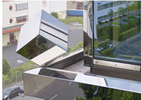
Fassadenbekleidung aus blankgeglühtem nichtrostendem Stahl vor und nach der Reinigung: Routineverfahren geben dem nichtrostenden Stahl seinen Hochglanz zurück. Foto: Christian Pohl GmbH, Köln (D)
