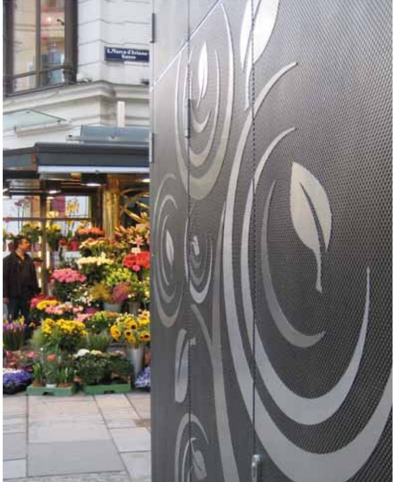
solution acide détermine l'épaisseur du film superficiel, l'interférence lumineuse et donc l'effet intense de coloration, semblable à l'effet d'irisation à la surface d'une bulle de savon ou d'un film d'huile. La gamme des couleurs (bronze, or, rouge, violet, bleu et vert) correspond à une augmentation de l'épaisseur du film passif de  $0,02 \mu\text{m}$  à  $0,36 \mu\text{m}$ . Les aciers inoxydables ferritiques ne permettent, quant à eux, qu'une coloration en gris foncé.
