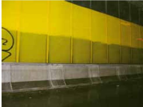
*Aucune trace de corrosion n'est apparue au nettoyage des piédroits du tunnel, en dépit des conditions de service très défavorables.*
