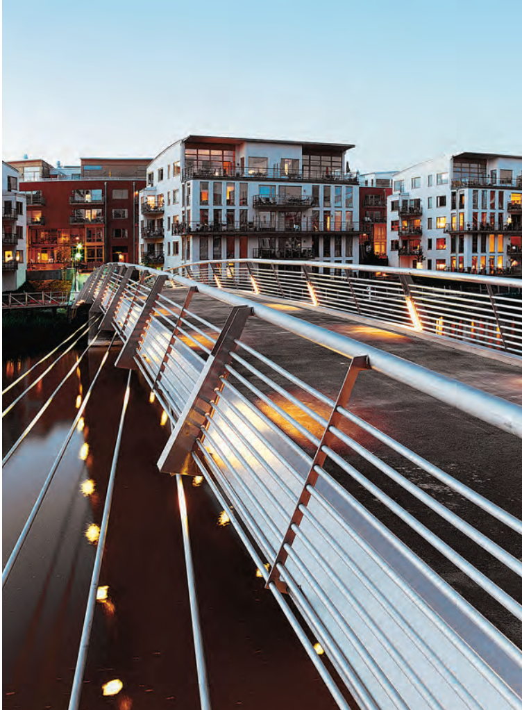
Fußgängerbrücke aus dem Werkstoff 1.4462. Foto: SBI, Stockholm (S)
