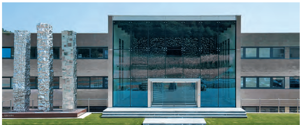
Fassade aus nichtrostendem Duplex-Stahl der Sorte 1.4162. Foto: Montanstahl, Stabio (CH)
