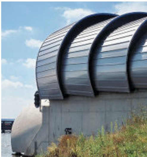
L'utilisation de nombreuses nuances permet d'assurer la résistance à la corrosion du matériau dans divers environnements, comme ici à proximité de la mer.
