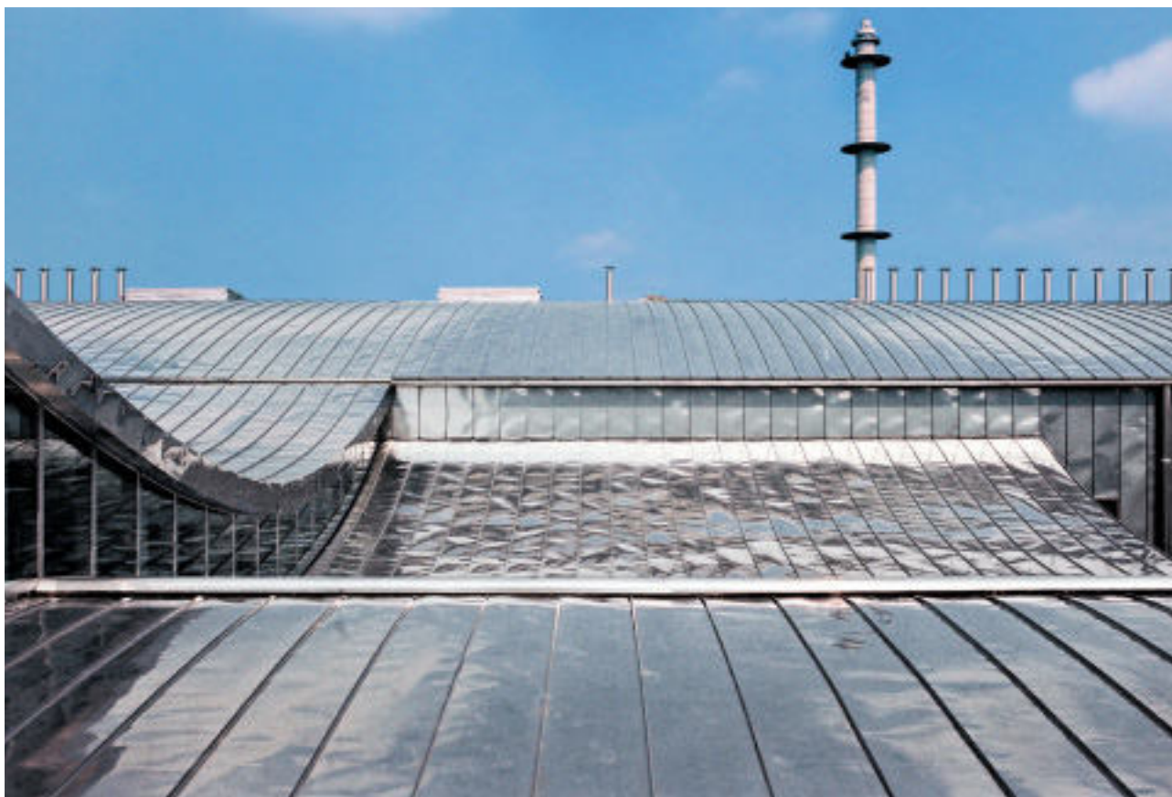
Foto: Jean-Luc Deru, DAYLIGHT s.p.a., Liegi
