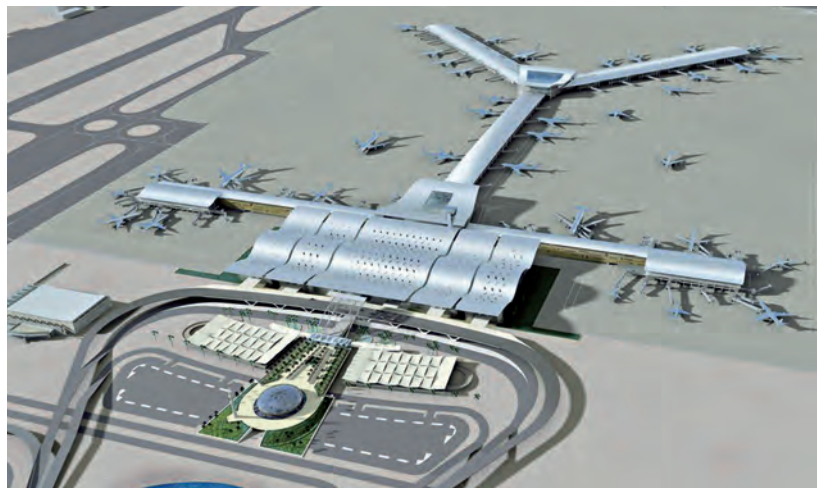
Der neue international Flughafen von Doha mit seinem Dach aus nichtrostendem Duplexstahl (Quelle: Qatar Airways)
