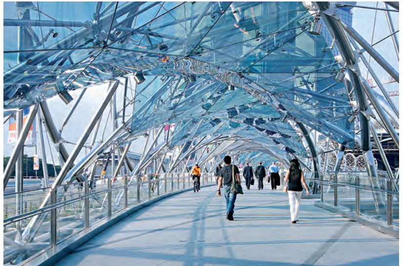
„The Helix“, Singapur, mit einem Tragwerk aus dem Duplexstahl EN 1.4462 (2205) (Quelle: Financial Dynamics/C. F. Jones)
