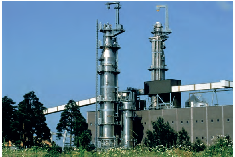
Kontinuierlicher Zellstoffkocher und Imprägnierreaktor aus dem Stahl EN 1.4462 (2205), Sodra Cell Mönsteras, Schweden (Quelle: Kvaerner Pulping)
