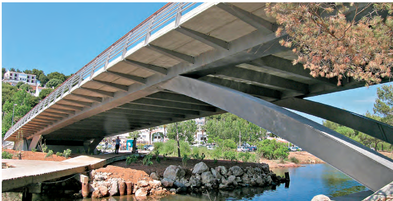
Brücke in Cala Galdana auf Menorca aus Duplex-Stahl der Sorte EN 1.4462 (2205); (Quelle: Pedelta)
