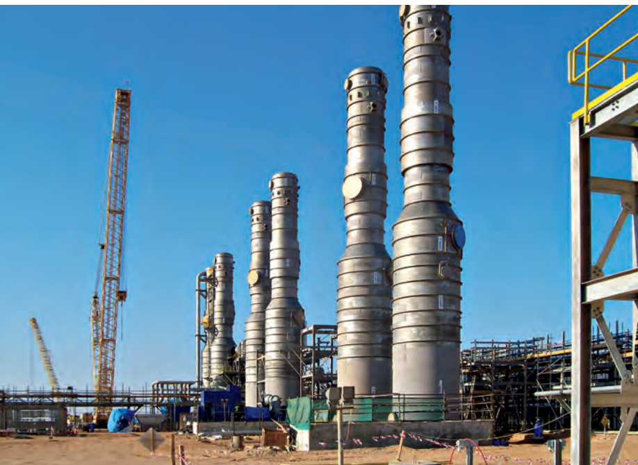
Ölauffangeinrichtung unter Verwendung des Stahls 1.4410 (2507) (Quelle: Aquatech)
