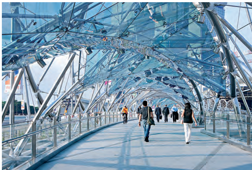
« The Helix », Singapour, avec une structure de support en acier duplex EN 1.4462 (2205) (Source : Financial Dynamics/C. F. Jones)
