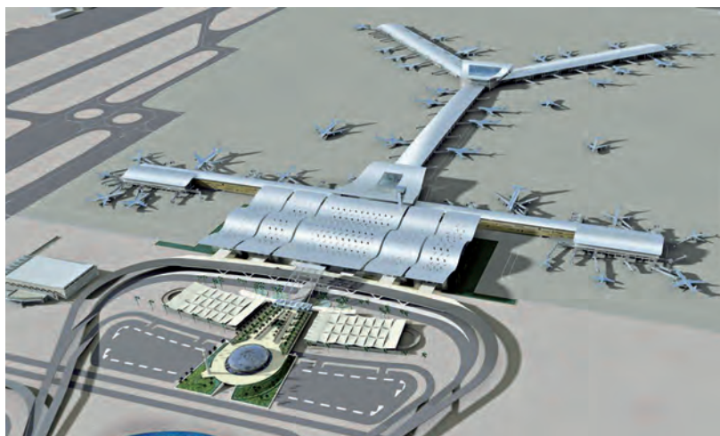
Nouvel aéroport international de Doha, avec une toiture en acier duplex (Source : Qatar Airways)
