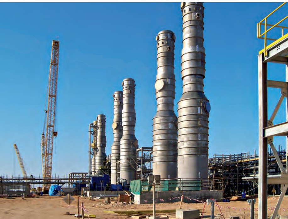
Installation de séparation du pétrole ; acier inoxydable EN 1.4410 (2507) (Source : Aquatech)
