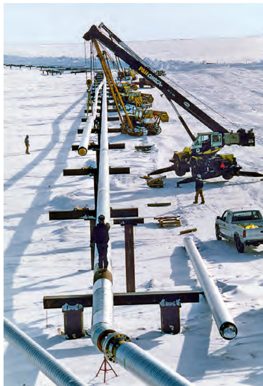
Pose, sur son supportage vertical, d'un oléoduc calorifugé Ø 24 in. en acier EN 1.4462 (2205), Prudhoe Bay (Source : Arco Exploration and Production Technology)
