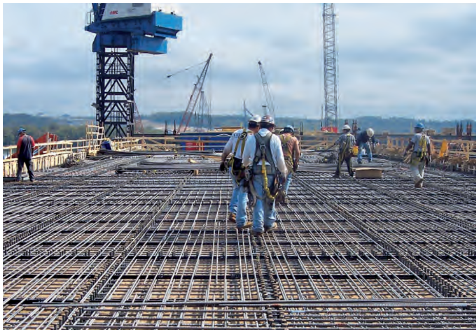
Installation d'armatures en acier inoxydable duplex sur un tablier de pont de grande largeur (Source : Hardesty & Hanover, LLP)
