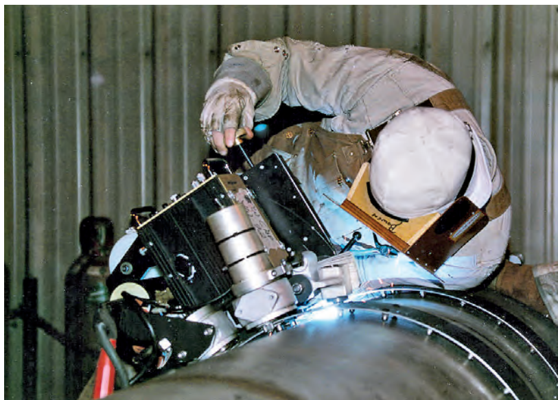
Soudage mécanisé de tubes d'oléoducs en acier inoxydable duplex de grand diamètre dans le nord de l'Alaska (Source : Arco Exploration and Production Technology)
