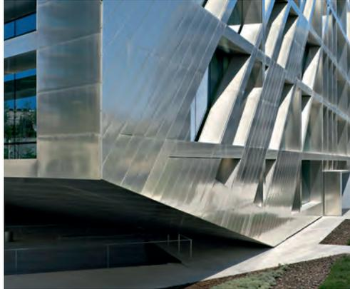
Die mit nichtrostenden Stahlpaneelen verkleidete Fassadestruktur aus Horizontalen, Vertikalen und Diagonalen umfasst den allseits verglasten Baukörper.
