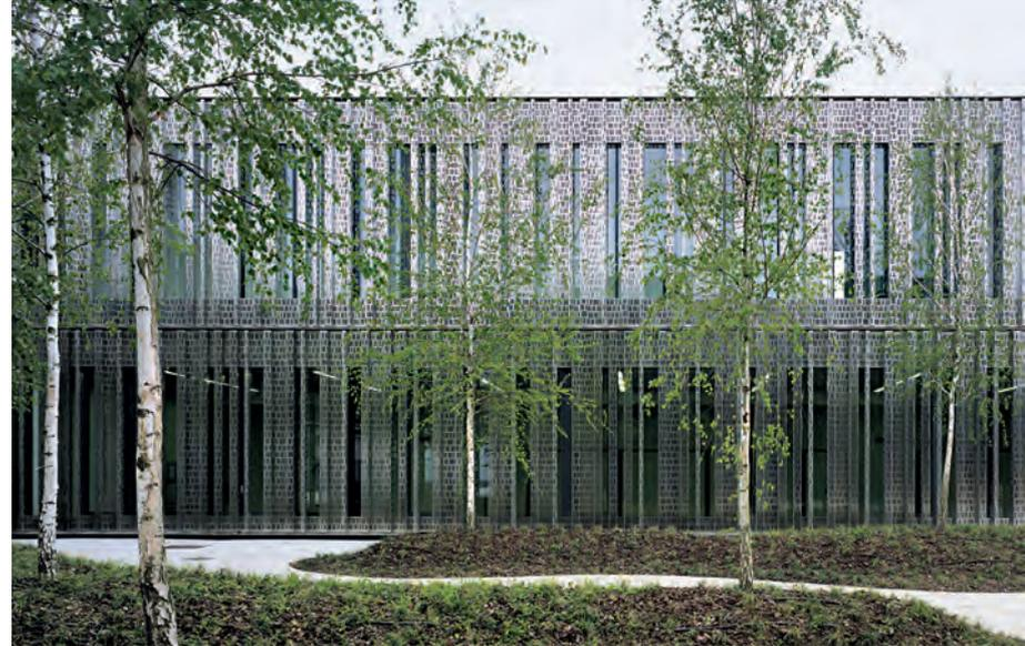
Zusätzliche vertikale Öffnungen in den 2 mm starken Blechen lassen gezielt Tageslicht in die dahinterliegenden, raumhoch verglasten Räume fallen. So trägt die ansprechende Gestaltung der Fassade zu dem nachhaltigen Energiekonzept des Gebäudes bei und fasst gleichzeitig alle Gebäudeteile zu einer Einheit zusammen.
