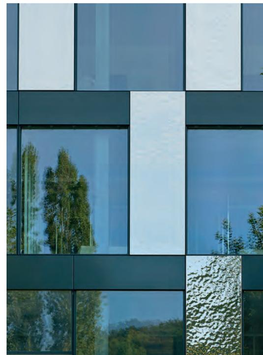
*Durch Zufallskomponenten in dem computergesteuerten Pressvorgang erhält jedes Edelstahlblech ein eigenes Prägebild.*
