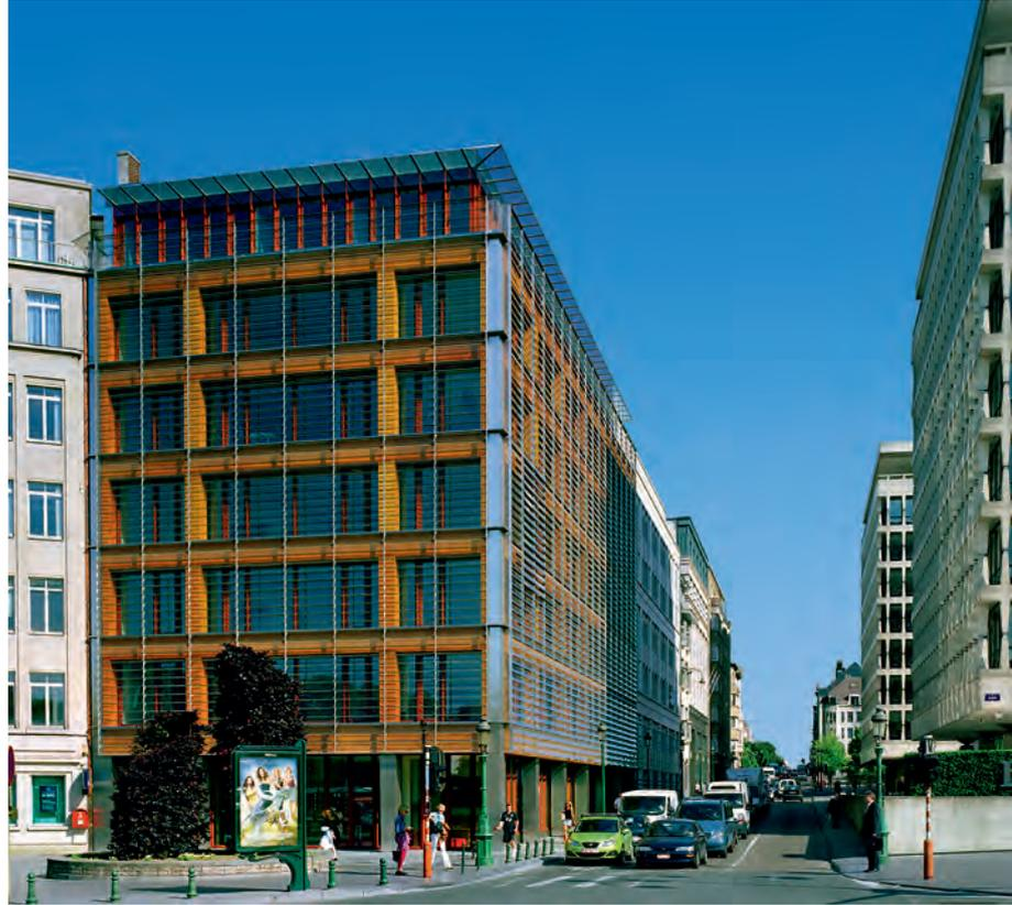
*Die hohe Festigkeit des nichtrostenden Stahls (EN 1.4301) ermöglichte eine äußerst schlanke Konstruktion der Glasfassade mit Profilstärken von 100 × 12 mm.*
