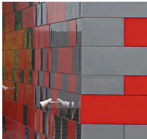
*Der geschlossene, an einen Industriebau erinnernde Baukörper erhält sein unverwechselbares Erscheinungsbild durch die unregelmäßige Anordnung der Stahlkassetten.*
