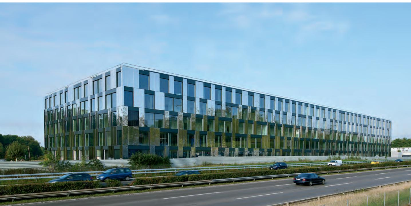
schutz bilden im Wechsel mit geschlossenen Metallelementen halber Breite die Außenwand.
