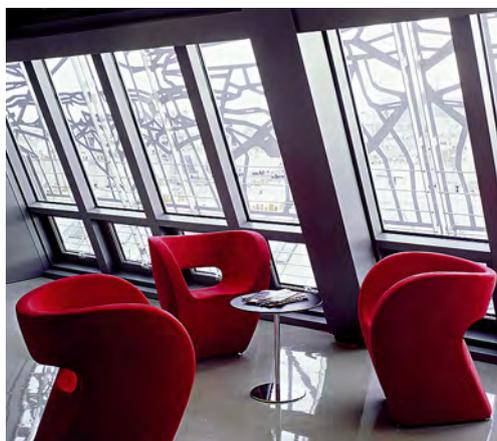
*Pannelli in acciaio inossidabile con un delicato motivo ottenuto mediante taglio al laser, che riduce la penetrazione dei raggi solari all'interno.*
