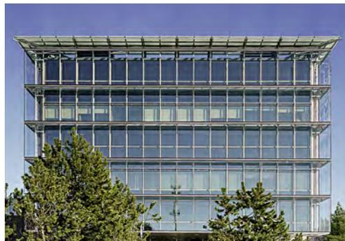
Questo palazzo per uffici costruito nel 1979 presso l'aeroporto di Vantaa è realizzato in cemento armato, con facciata in alluminio e vetro. Nel corso degli anni sono apparse delle lesioni sulla facciata a causa della dilatazione termica, con notevoli danni.
