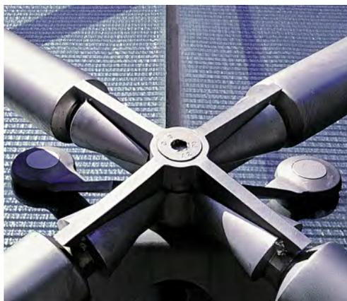
*È necessario un solo bullone per tenere insieme i diversi componenti sui punti di giunzione della struttura in acciaio inox. Questo ha permesso il rapido montaggio in opera.*
