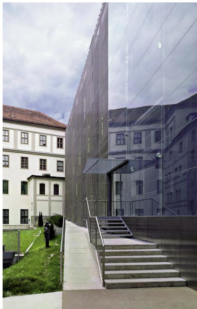
*Se in una successiva variazione d'uso la scala di emergenza non fosse più necessaria, l'intera struttura potrà essere smantellata senza lasciare tracce visibili sulla facciata dell'edificio storico.*
