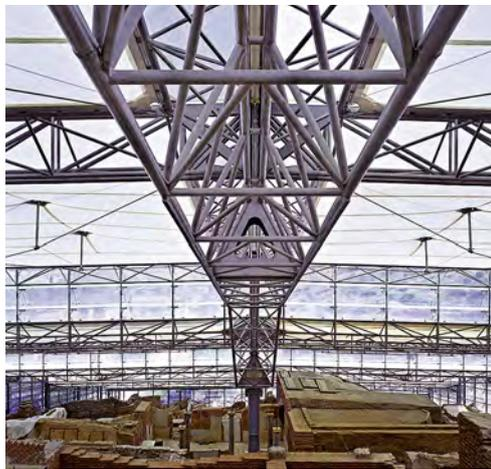
*La struttura in acciaio inossidabile è stata fabbricata e preassemblata in Austria, poi trasportata ad Efeso e montata in opera nell'arco di pochi mesi.*
