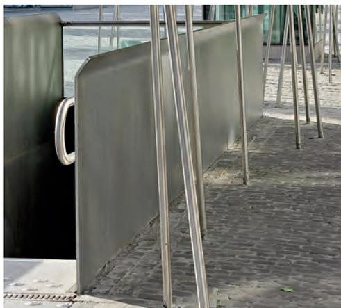
*Les garde-corps des descentes d'escalier sont constitués de tôles inox de 12 mm d'épaisseur, rigidifiées par un pli en partie supérieure.*
