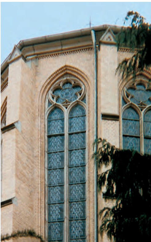
Anwendung eines verzinnten ferritischen Stahls 1.4510 am Beispiel einer denkmalgeschützten Kirche
