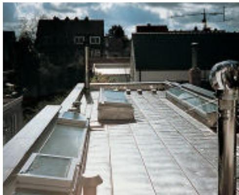
*I nastri saldati di acciaio inossidabile sono tipicamente utilizzati sui tetti piani, con inclinazione minima o del tutto assente, per i quali nessun altro metallo fornirebbe la soluzione appropriata.*
