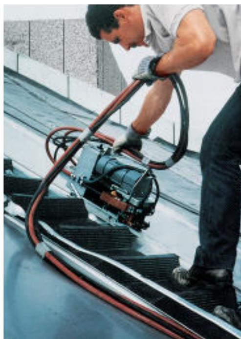
*Macchina saldatrice in continuo per l'attorney. Gli elettrodi di saldatura e il trasformatore sono raffreddati ad acqua.*
