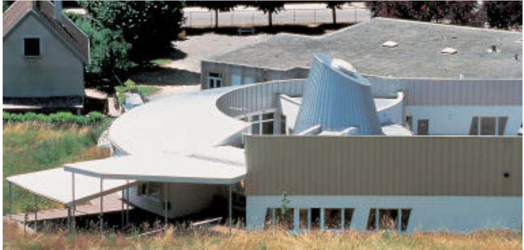
*Sia i tetti che gli alti parapetti delle facciate sono stati rivestiti con lo stesso materiale – acciaio inossidabile grigio opaco.*
