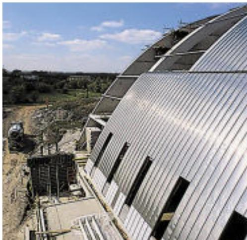
*Il tetto in acciaio inossidabile con giunzioni aggarrate è disposto in sezioni orizzontali per comodità di movimentazione dei nastri di acciaio e per consentire un'adeguata circolazione dell'aria nel tetto ventilato.*
