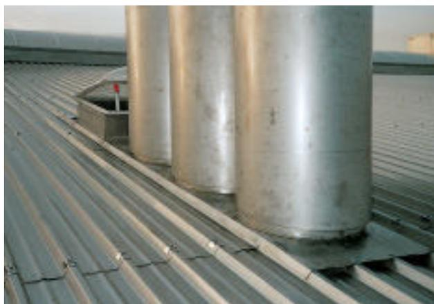
*I camini, la grondaia, i pluviali e i fissaggi sono tutti realizzati in acciaio inox, così come la lamiera grecata.*
