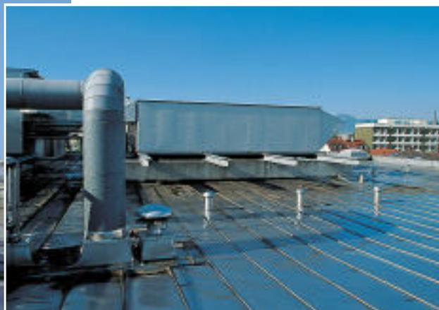
*Le aziende che si occupano della trasformazione del latte devono prestare particolare attenzione all'igiene; l'impermeabilità delle coperture di acciaio inossidabile ne facilita la pulizia.*
