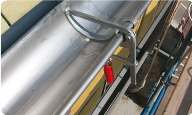
Kleben von Dachrimmenelementen aus verzinnem 1.4520 [430]Ti.
