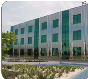
1.4521 (444), gebürstet (No. 4), horizontale Paneele, Vivo-Gebäude, Rio de Janeiro, Nucleo Inox, Brasilien (Küstenzone)
