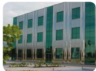
Teilverkleidung eines Gebäudes aus 1.4521 (444), Brasilien.
