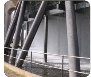
1.4003 (410), Tragkonstruktion (Kühlturm), Südafrika
