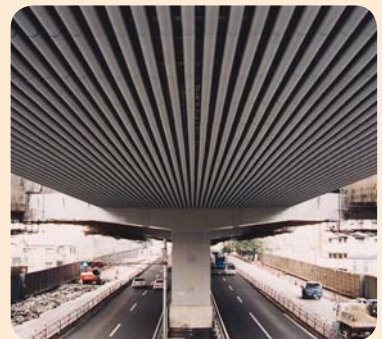
Schallabsorbierende Brückenverkleidung, Japan.
