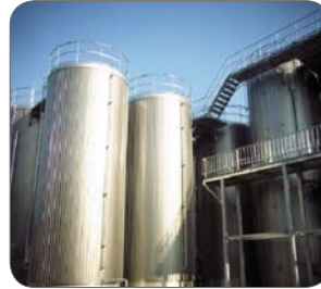
SUS430J1L (1.4016/430), farbig kunstharzbeschichtete Außenverkleidung, JSSA, Japan
