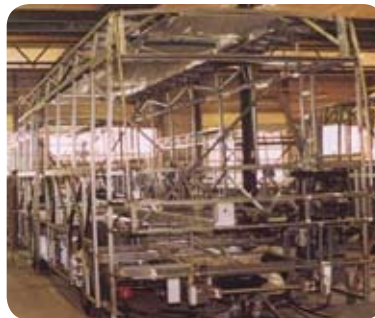
Ossature de bus en nuance 410, Afrique du Sud.
