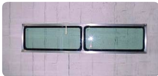
Fenêtres collées à un châssis tubulaire en 1.4003.
