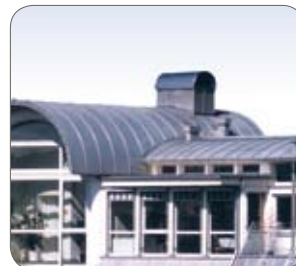
Nuance 430Ti (technique du joint debout), Ugine & Alz, Autriche
