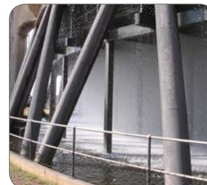
Tipo 1.4003/410, packing di una torre di raffreddamento (X-grid), Sud Africa
