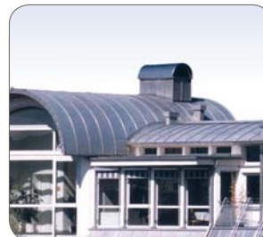
Tipo 430Ti (tecnica standing seam), Ugine e Alz, Austria
