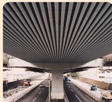
Barriera antirumore di un'autostrada, Giappone.
