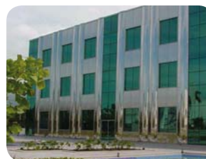
Edificio parzialmente rivestito in 444, Brasile.
