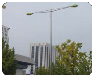
Tipo 1.4510/439, tubo saldato elettrolucidato, KOSA, Seoul, Corea del Sud
