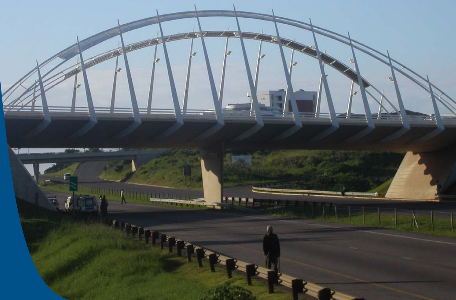
PONTE AUTOSTRADALE A DURBAN, SUD AFRICA, IN ACCIAIO INOSSIDABILE FERRITICO VERNICIATO.
