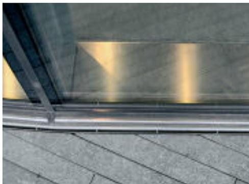
*Für die City Hall in London wurde eine Schlitzrinne mit hochglanzpolierter Edelstahloberfläche entworfen, die entlang von geraden und gebogenen Glasfassaden für eine sichere und unauffällige Entwässerung sorgt.*
