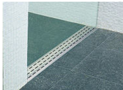
Auch im privaten Bereich finden sich Rinnen aus Edelstahl z.B. als bodengleicher Duschabfluss.
