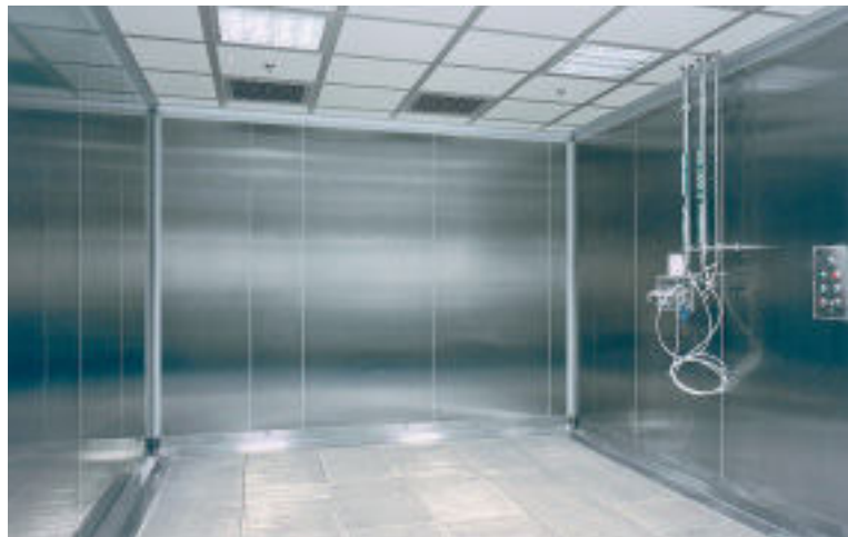
In dem Waschraum eines pharmazeutischen Betriebes sind sowohl Wände als auch Bodenroste aus Edelstahl mit der Werkstoff-Nr. 1.4301 gefertigt.
